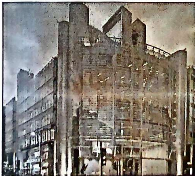
تصویر ۱-۳۸- نمای خارجی از ساختمان هلیکون
