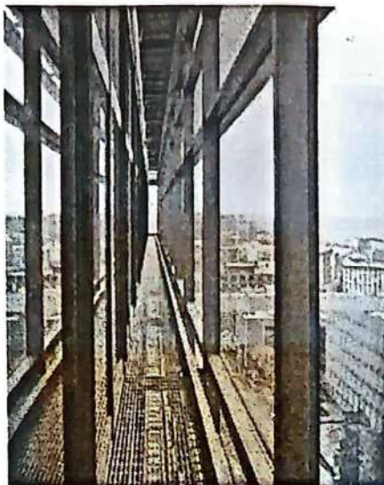
تصویر ۶-۱۵۰- نمای حفره ساختمان
