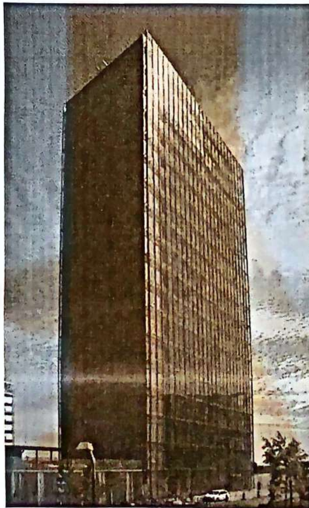
تصویر ۶-۱۰۴- نمای بیرونی ساختمان
