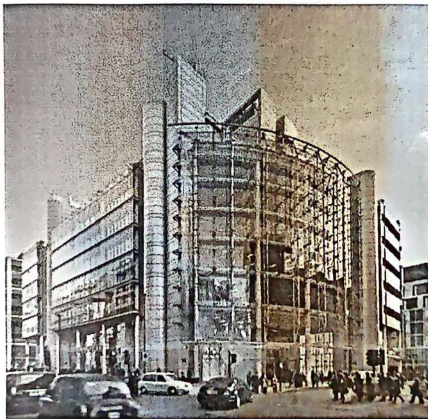
تصویر ۶-۱۲۷- نمای خارجی ساختمان
