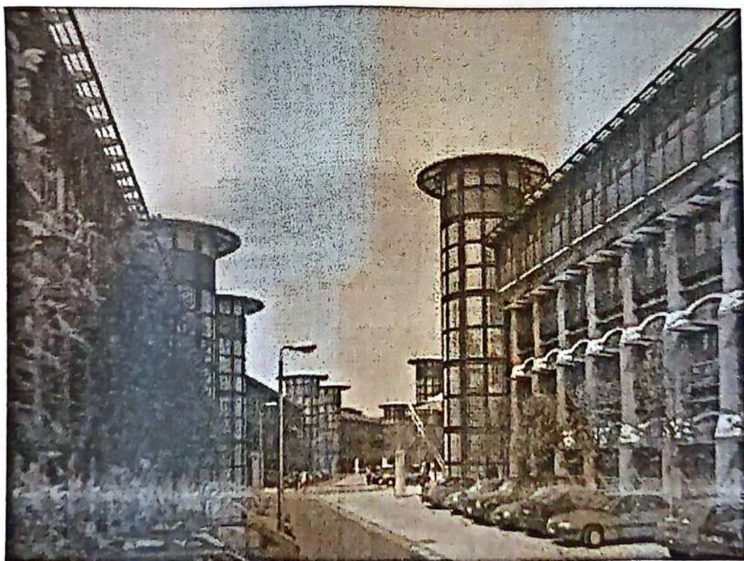
تصویر ۶-۱۳۷- نمای خارجی ساختمان
