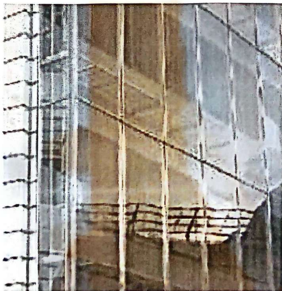
تصویر ۶-۱۰۸- نمای بیرونی ساختمان
