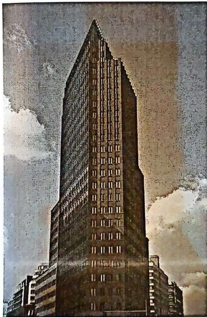
تصویر ۶-۳۳- نمای خارجی ساختمان
