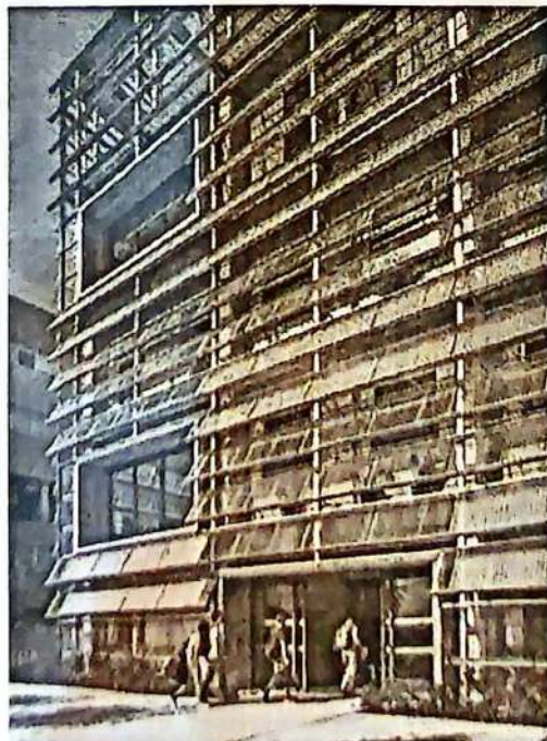
تصویر ۲-۴۴- استفاده از مصالح چوب جهت کاهش صدا
