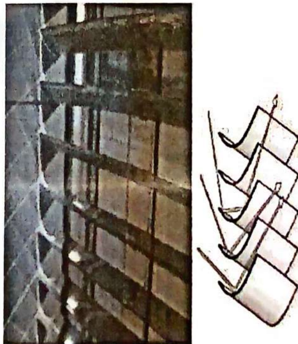
تصویر ۵-۴۰- لوورهای فلزی سهمی شکل
