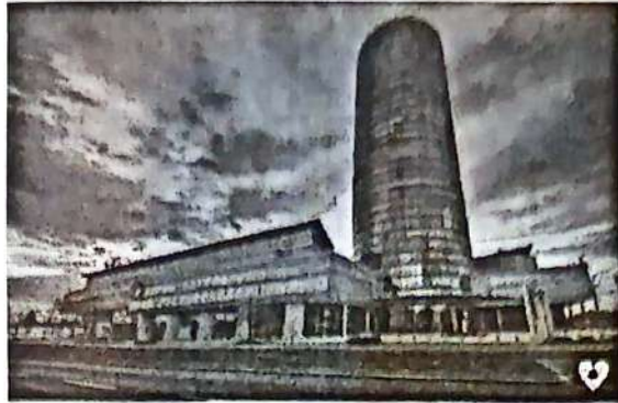
تصویر ۶-۶۰- نمای خارجی ساختمان
