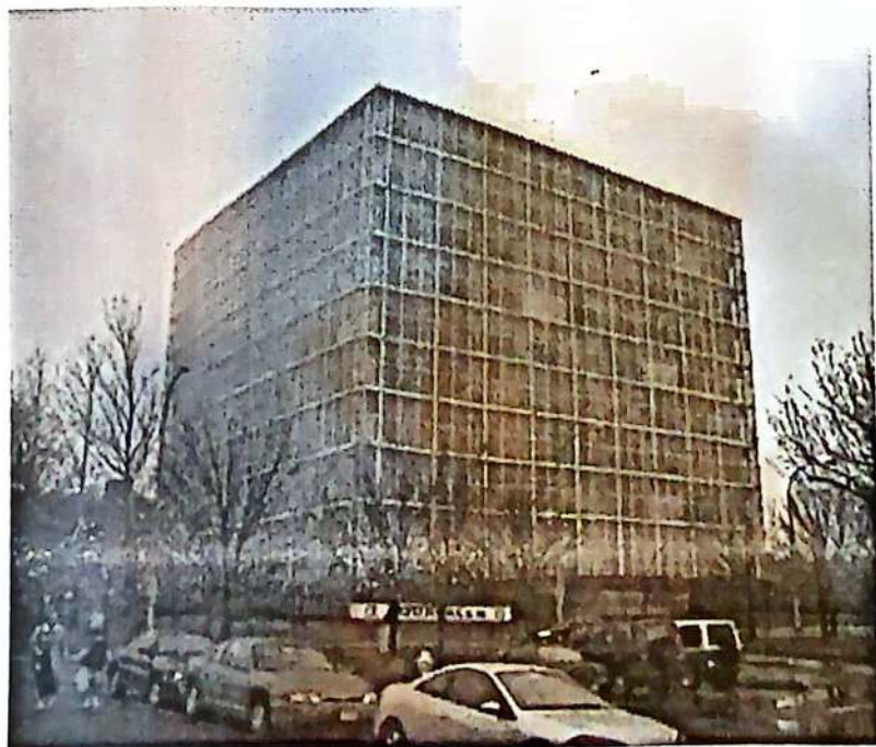
تصویر ۶-۱۵۲- نمای ساختمان اکسیدنتال
