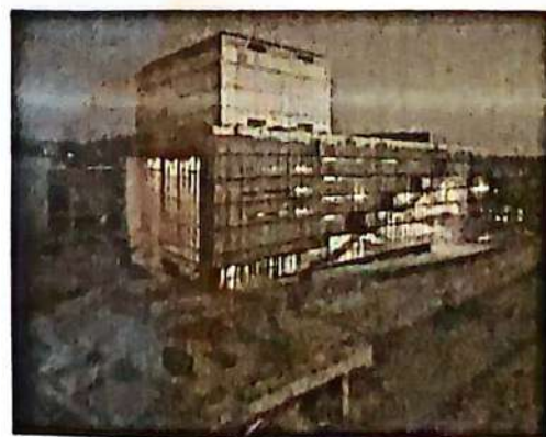
تصویر ۶-۱۴۶- نمایش شب ساختمان
