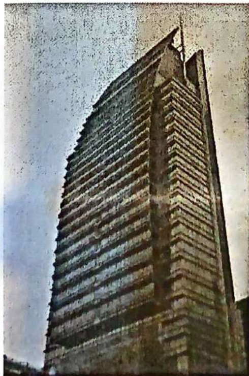
تصویر ۲-۴- ساختمان پکینگ زد
