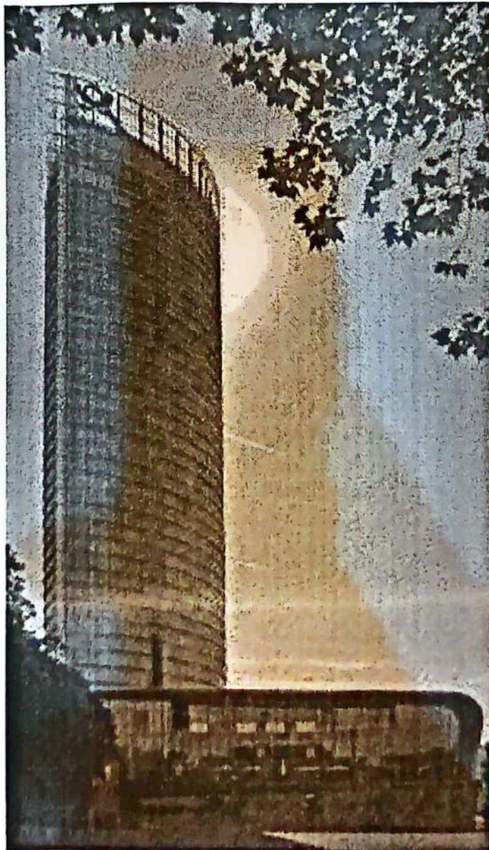
تصویر ۶-۵۶- نمای خارجی ساختمان
