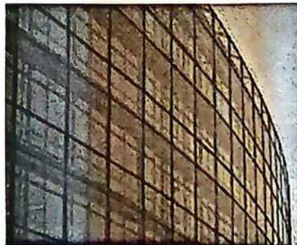
تصویر ۶-۱۲۰- نمای بیرونی ساختمان
