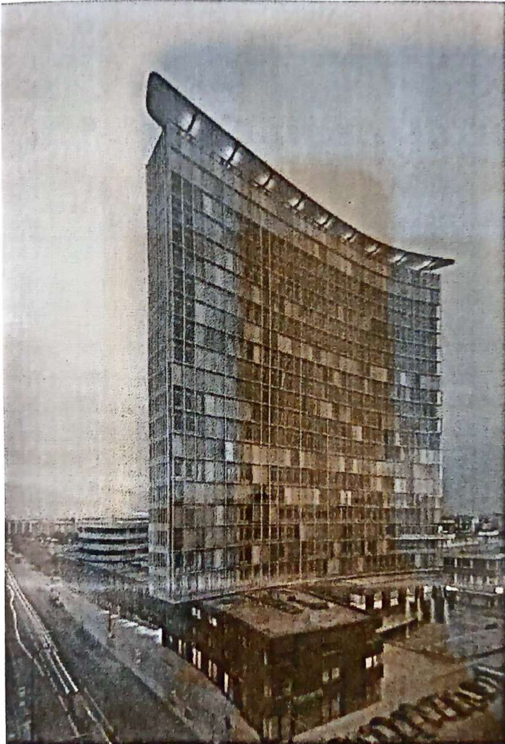
تصویر ۶-۲۵- نمای خارجی ساختمان
