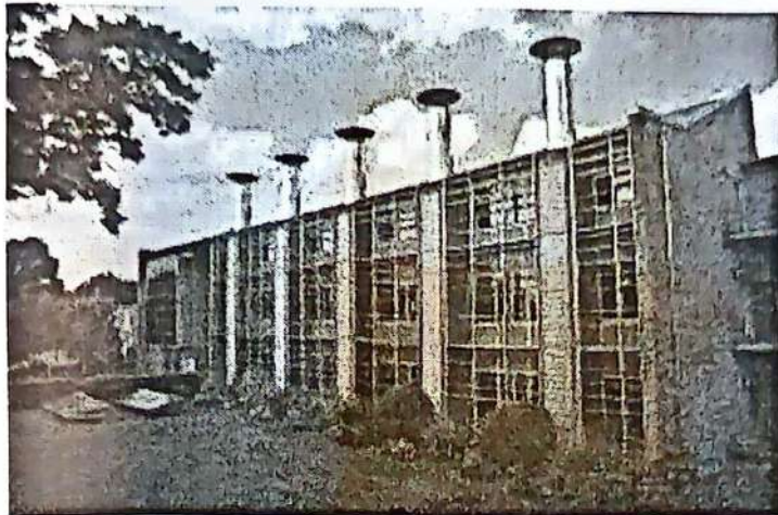
تصویر ۶-۱۳۴- نمای بیرونی ساختمان
