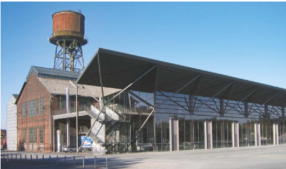
Fig. C1.14 Century Hall (Jahrhunderthalle) at Bochum/Germany. Architects: Petzinka Pink Technologische Architektur®, Duesseldorf
