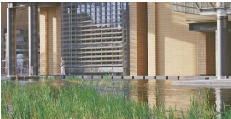
Fig. B2.27 Rainwater collection in Berlin, Potsdamer Platz
